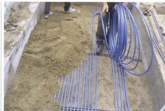
Bild 2: Als Erdspeicher wurden 1950 m Solerohr in vier Lagen angelegt
