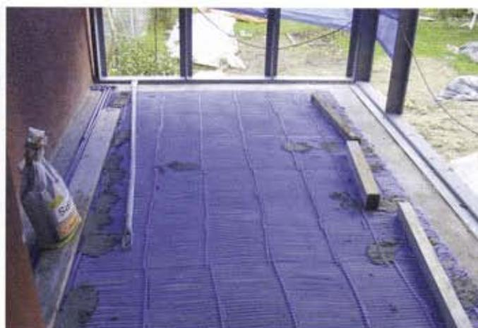
Bild 3: Verlegen der Rohre für die Fußbodenheizung
