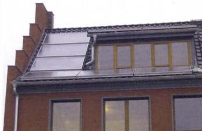
Bild 1: Solarkollektor auf dem Dach des sanierten Reihenendhauses
